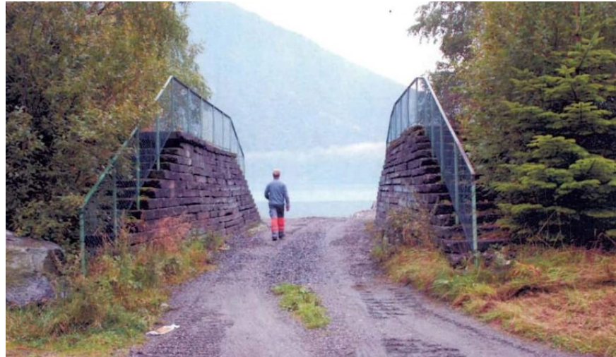
Dike to protect from tsunamis in Årdalsvatn, Norway (Source: Årdal kommune)
