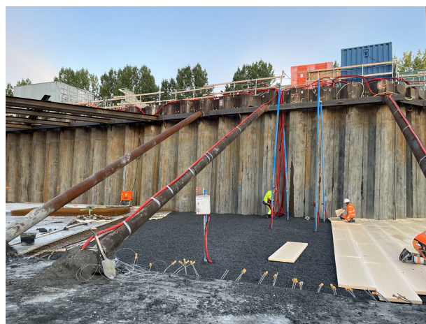
Figur 2.3.2: Instrumentert seksjon ved steg 2.
