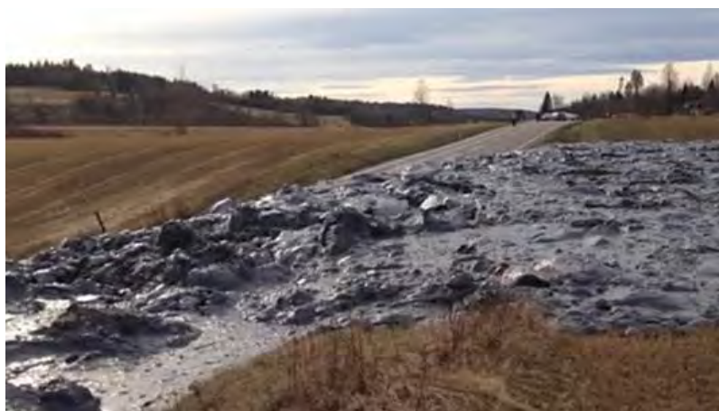
Figur 1.2: Utglidning av massedeponi i Hobøl (Askim, 2014)
