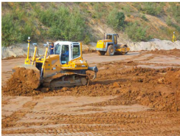
Figur 2.4: Utlegging av leire ved hjelp av doser og vals ved deponi i Tyskland (Scheiber and Schröder, 2014)
