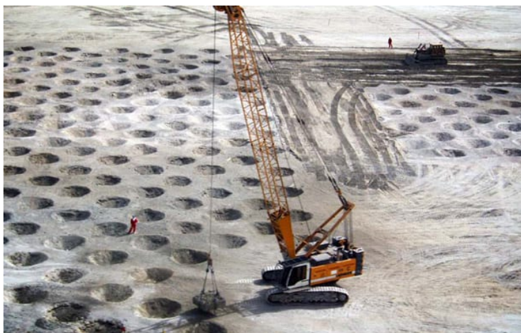
Figur 7.1 Effekten av dypkomprimering. Kilde: civildigital.com .
