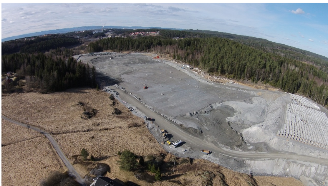
Figur 6.2. Oversiktsbilde av fylling ved Follobanen (bilde: Bane NOR).
