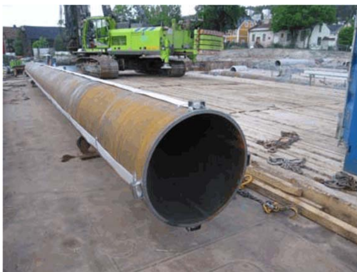
Figur 35. Vertikaldren montert på stålrørspel ved Øvre Sund bru (fra Tefera et. al, 2011)
