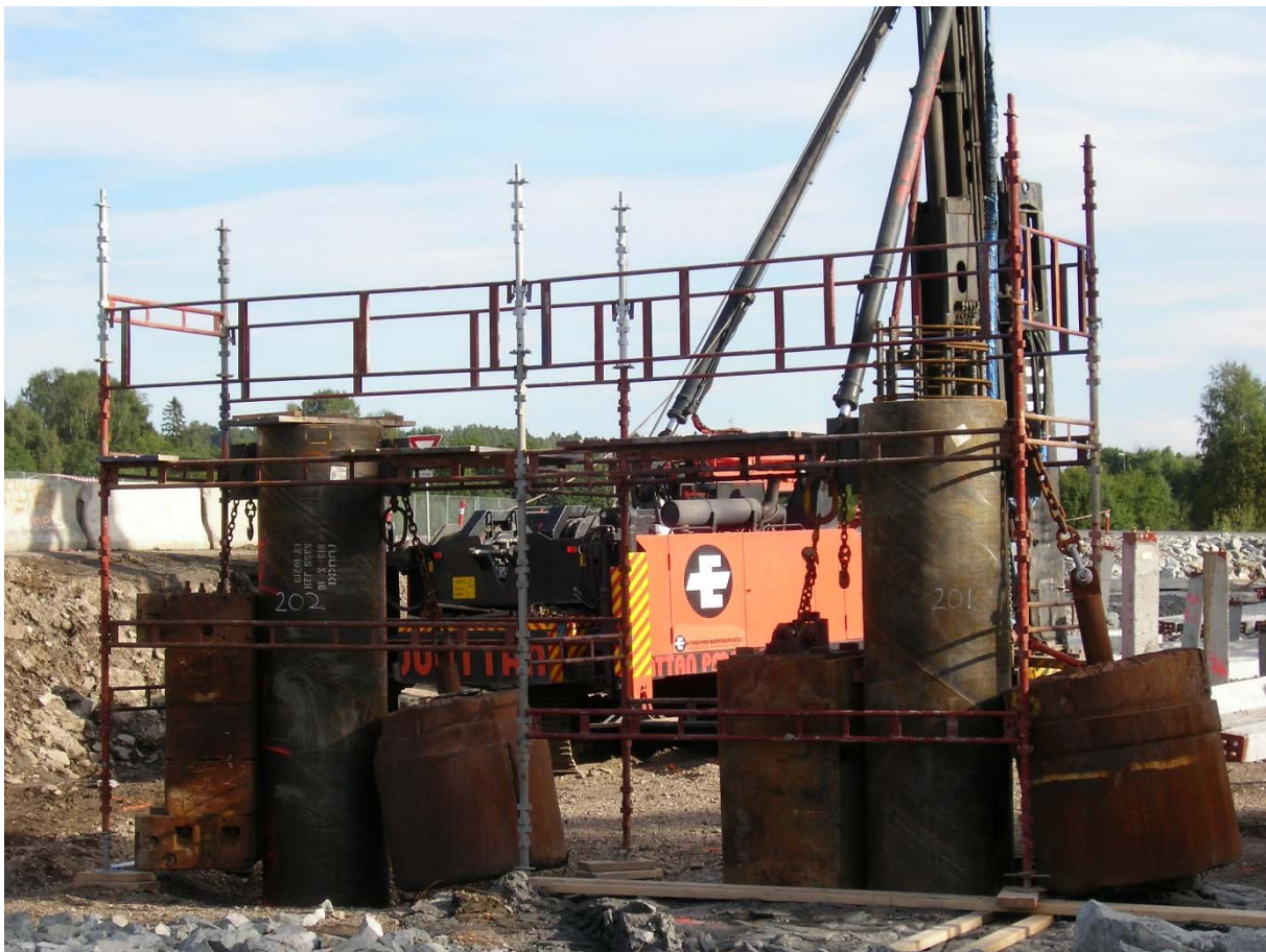
Figur 26 Eksempel på overhøyde og tilleggsballast på lukkede stålørpeler rammet i kvikkeleire (Foto NGI)
