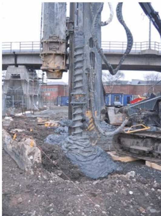
Figur 32. Forboring med naver før peleramming (fra Edstam, 2012)
