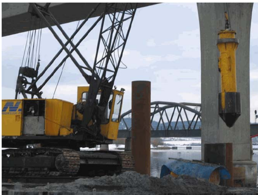
Figur 34. Dor brukt ved installasjon av rammet stålrør ved bygging av nye Drammensbrua fra, SVV (2006).
