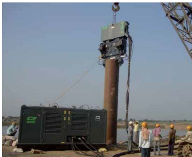
Figur 14: Bilder av vibrolodd hentet fra ICEs hjemmesider www.ice-holland.com
