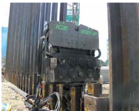
Figur 13: Bi Ider av vibrolodd hentet fra ICEs hjemmesider www.ice-holland.com , og fra brosjyre fra Pajot, leverandør av ulike typer lodd, www.pajot.com
