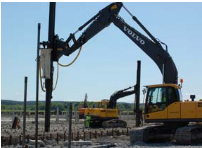
Figur 44 Illustrasjon kran for peleramming for mikropeler, kilde: www.hercules.se
