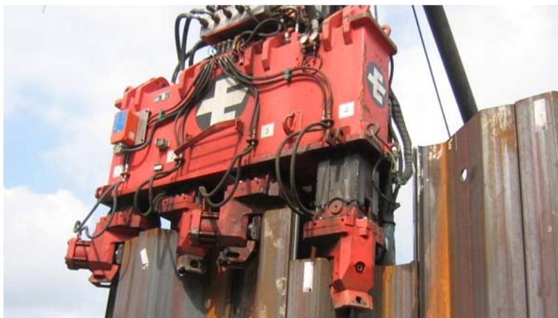
Figur 25 Presseenhet type ABI Hydropress HZ630. Kilde: Entreprenørservice: www.entreprenørservice.no
