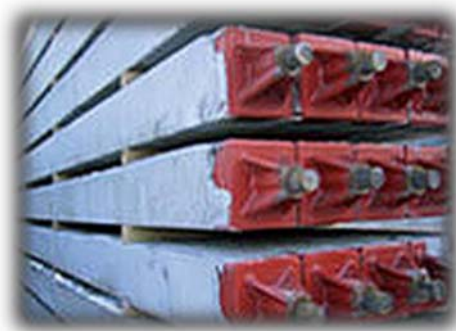
Figur 31 Bergspiss på prefabrikkert betongpel. Kilde: Kynningsrud: www.kynningsrud.no
