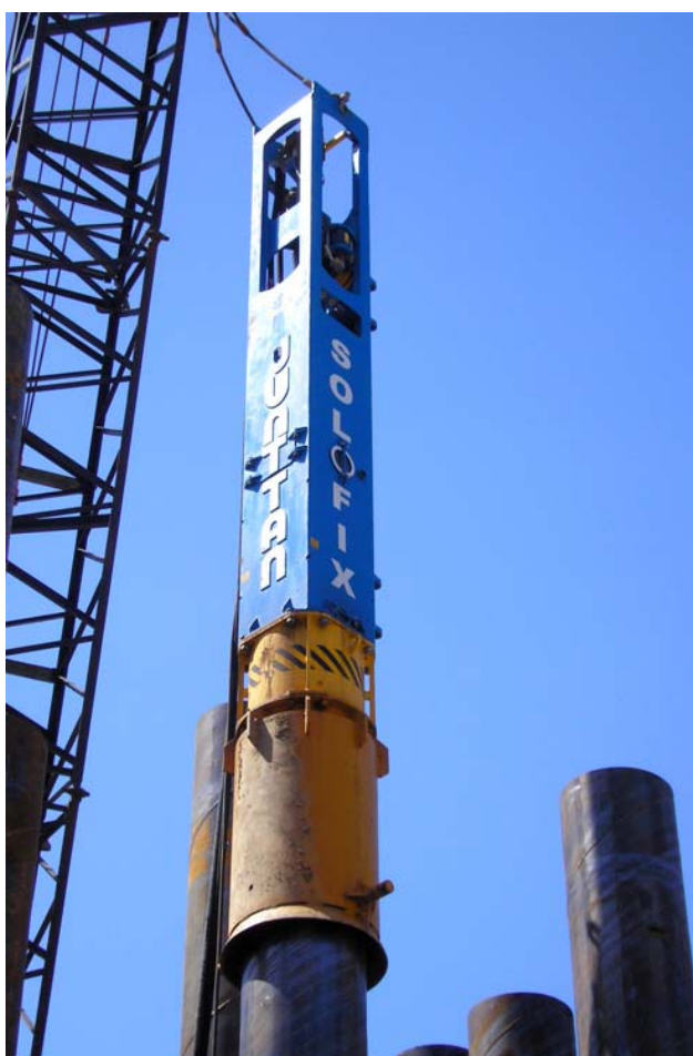
Figur 45 Illustrasjon guide for lodd med føring montert på pel, kilde: www.junttan.com
