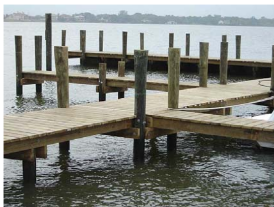
Figur 42 Illustrasjon av tre-peler, kilde: http://www.buildingproductsplus.com/images/dock_pilings-BIG.jpg
