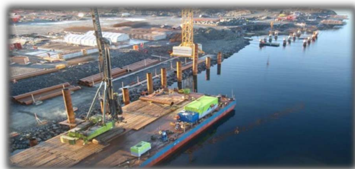
Figur 38 Illustrasjon av byggeplass med stålørspeler. Kilde: Kynningsrud fundamentering
