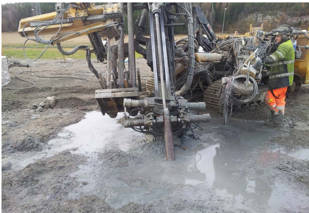
Figur 4-10: Bilde av boring av forankringszone i berg etter at foringsrør er boret ca. 0,4 m inn i berg stag E106.
