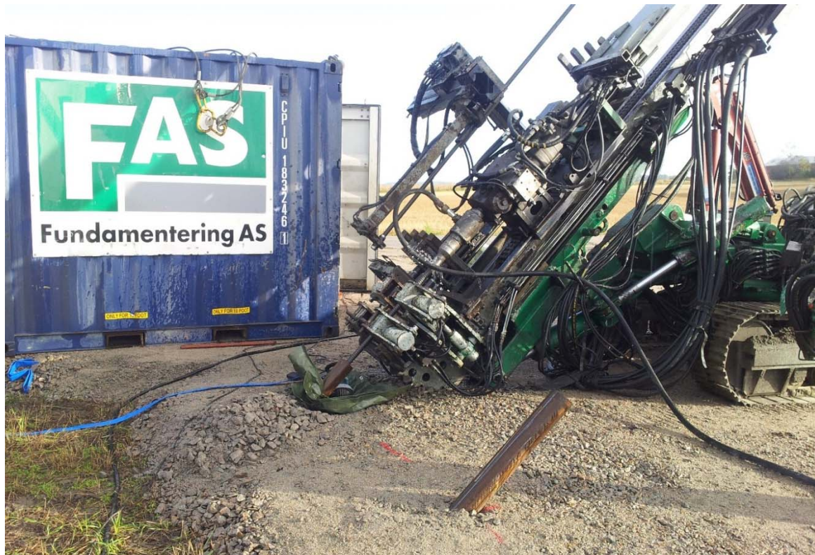
Figur 4-1: Bilde av borerigg type Klemm KR803-1 oppstilt for boring av Ischebeck stag i felt A.
