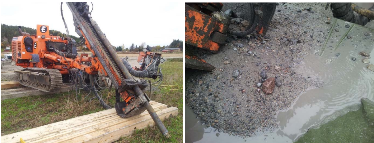
Figur 4-8: Til venstre; bilde av borerigg Tamrock CHA 700 med topphammer klargjort for boring med Odex 90 i felt D. Til høyre; bilde av borkaks og utspylte morenemasser ved boring av stag D104.
