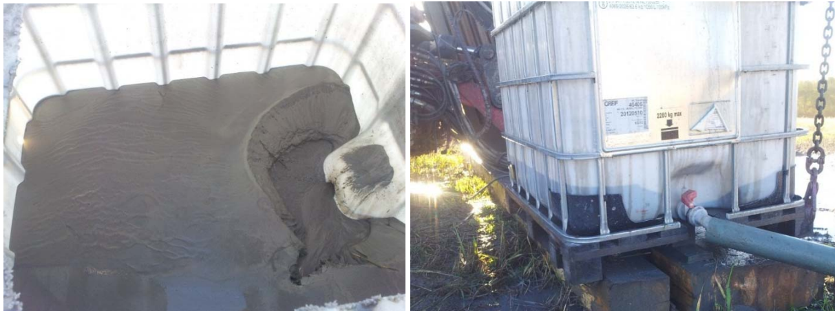
Figur 4-4: Bilde av oppsamlet borkaks ved boring av stag B106. Sedimentert ca. 150 l silt/finsand i bunn etter tømming av spylevann.
