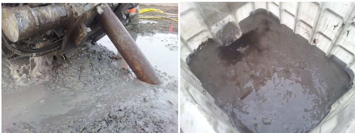
Figur 4-11: Til venstre; bilde av leire som er boret ut fra stag E106. Til høyre; bilde av oppsamlet leire/silt (ca. 100 l) i bunn av tank etter tømning av spylevann stag E105.
