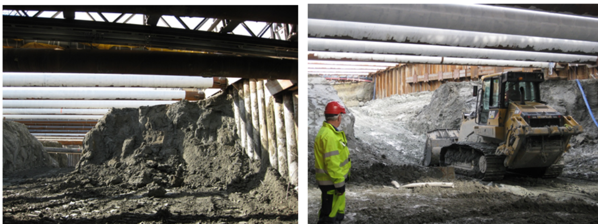
Figur 9. Kvikkleire er blitt stabilisert og ligner fast tørrskorpeleire i «svak sone»
