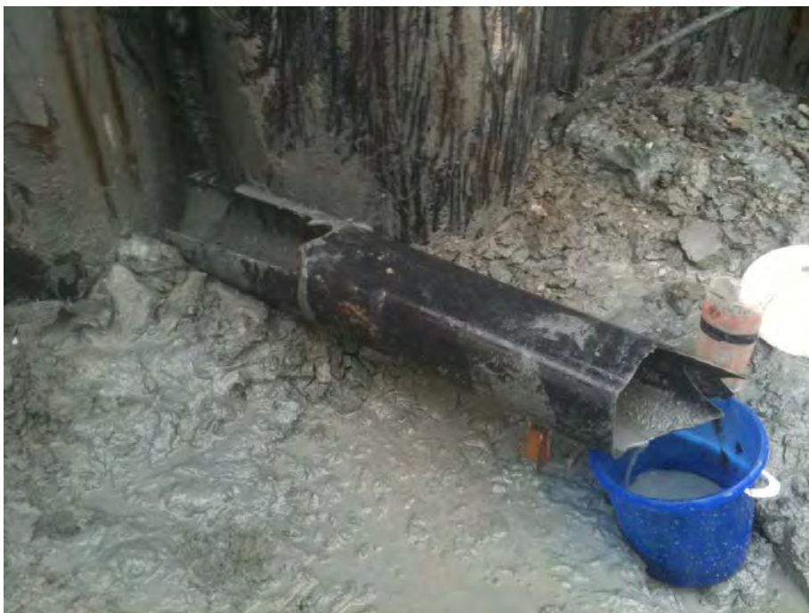
Figur 10-1. Inflow till schakt med schaktbotten på ca nivå -1m. Inflowdes mättes till 1.5L/min mellan spont 69 och 70 på östra sidan 2011-08-17.
