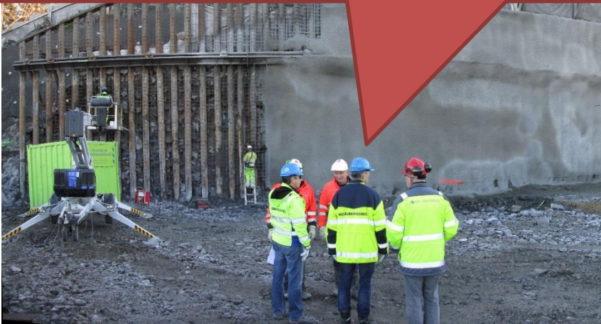
Illustrasjonsfoto «Befaring på byggeplassen»
